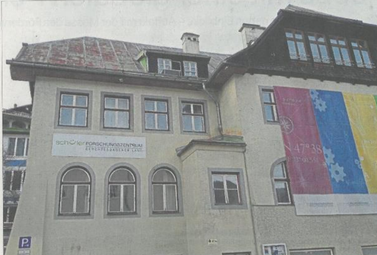
Im ehemaligen Gymnasium von Berchtesgaden ist das Schülerforschungszentrum untergebracht.
